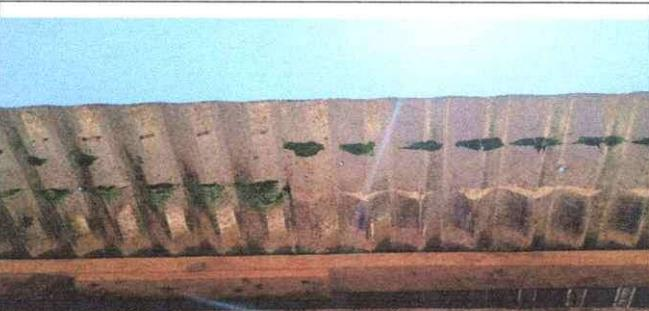
Foto 5: Cambio de estructura de escuela por costaneras galvanizadas ya que se cuenta con vigas de madera en mal estado y quebradas.
