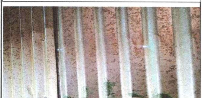
Foto 4: Cambio de techo por laminas troqueladas aluzinc ya que se cuenta con láminas galvanizadas con agujeros en época de lluvia se tiene filtraciones en las mismas.
