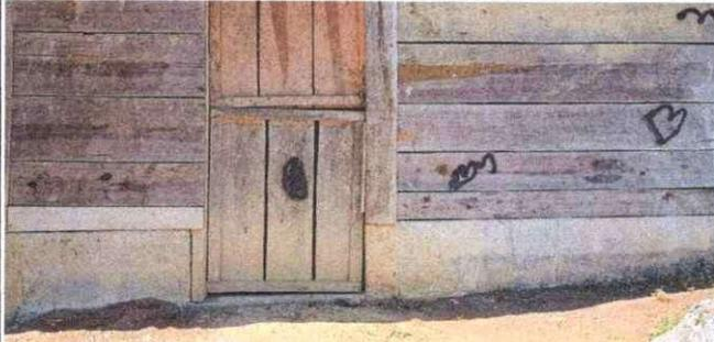
Foto1: Sustitución de muro interior de aula con block (15cm X 20cm X 40cm, se cuenta actualmente con madera en mal estado.
